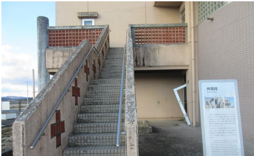
（震災翌日に、人々が避難経路として使用した階段）
