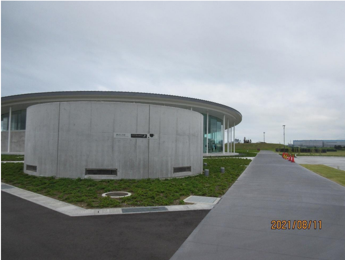
(みやぎ東日本大震災津波伝承館)
