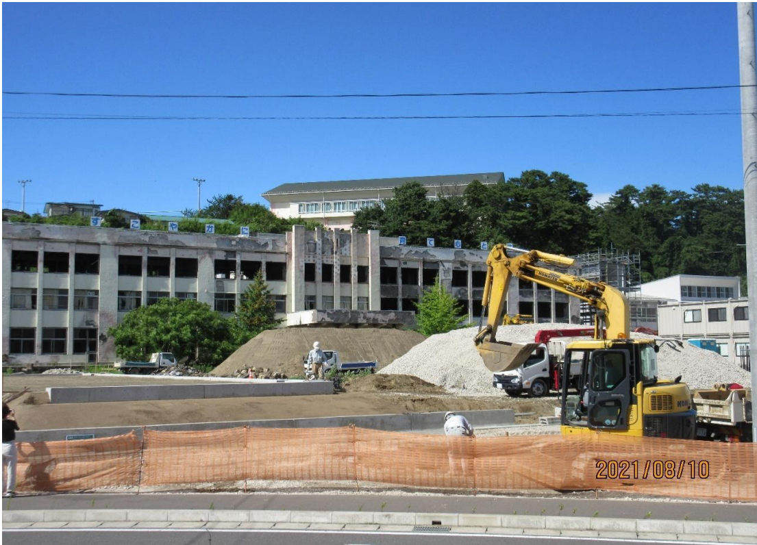
(遺構にするために工事中の門脇小学校)
