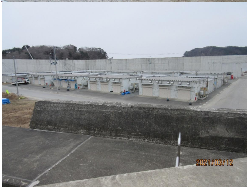
(田老の防潮堤：上が震災前からあったもの、下が 2021 年時点で建設中)
